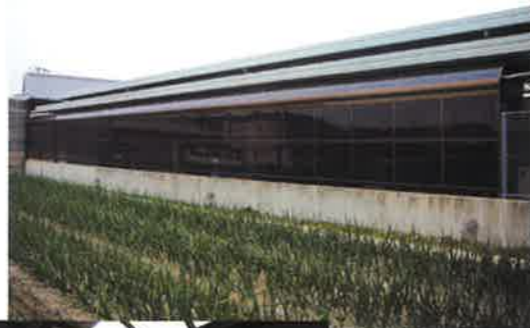
▲通路に増設されたテラス
